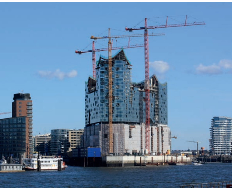
Elbphilharmonie Hamburg im Bau.
