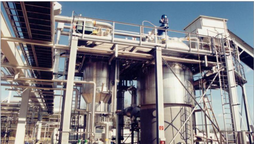
Abbildung 9: Rechts das Aufschmelzgefäß, links der Crackreaktor.
