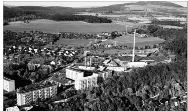
Daseinsvorsorge durch kommunale Eigenbetriebe sichern. Im Bild: Stadtwerke Meiningen GmbH
